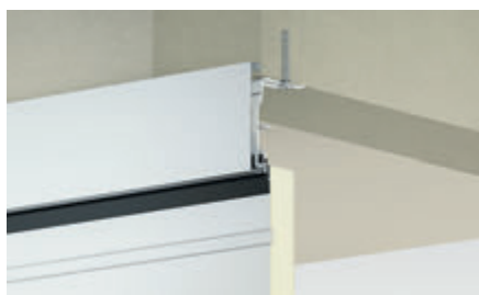
Монтаж перед проемом
